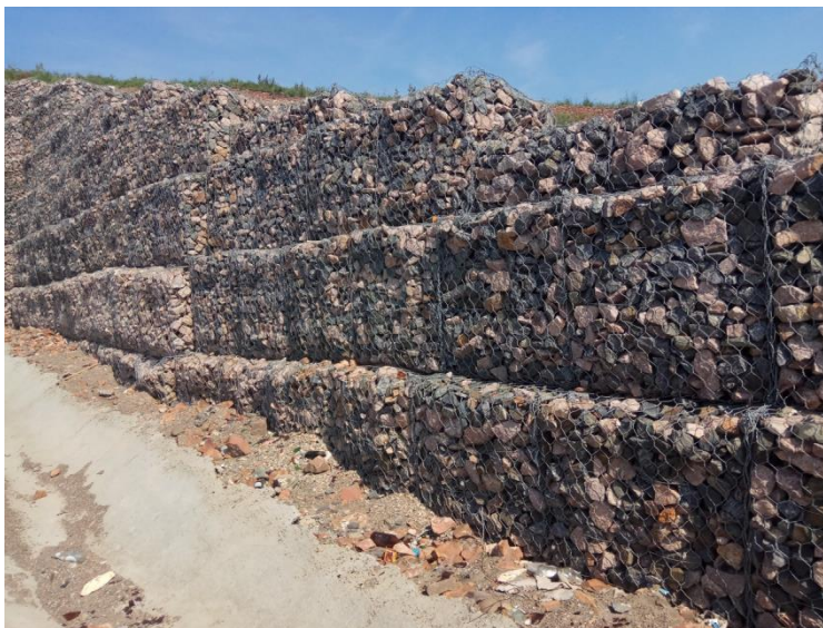
Рисунок 3. Габионные конструкции на серпантине на горе Сопка г. Красноярск
